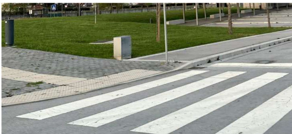
Fig. 13 Passagem pedonal com rebaixamento do lancel do passeio em Chaves
