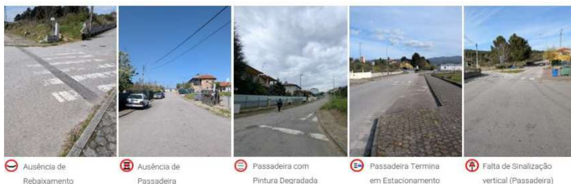
Fig. 15 Tipologia das Barreiras de Acessibilidade – Subgrupo de Passadeiras
