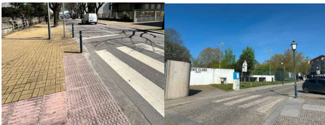
Fig. 99 Exemplo de passadeiras com piso podotátil
