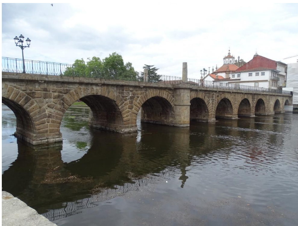
Fig. 1 – Fotografia de alçado da ponte
