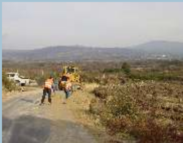
Enchimento de bermas e limpeza de valetas em várias localidades do concelho
