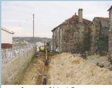
Saneamento Básico de Travancas
