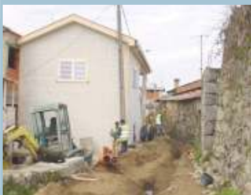
Saneamento Básico de Águas Frias
