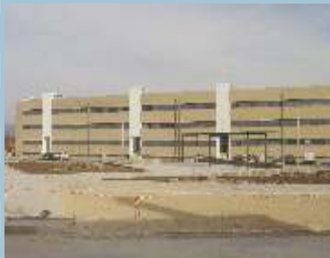
Arranjo urbanístico junto ao Estádio Municipal
