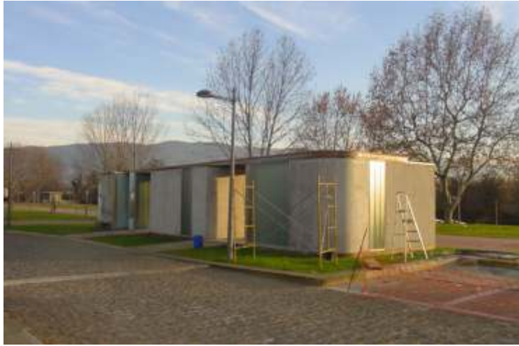
Remodelação da área Termal - POLIS
