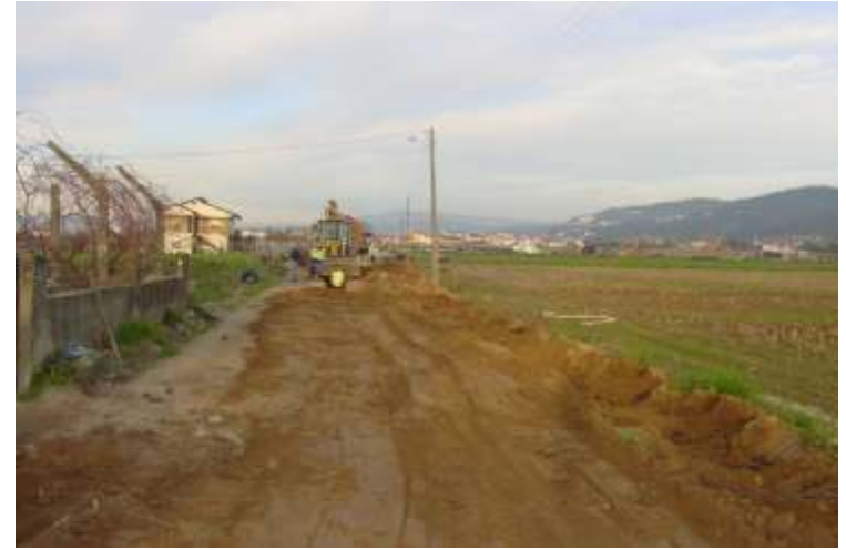
Saneamento da Madalena
