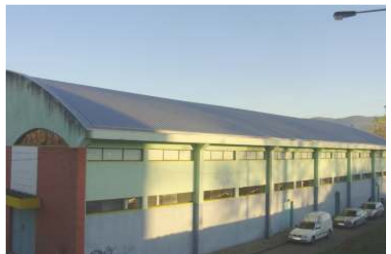
Cobertura do Pavilhão Gimnodesportivo
