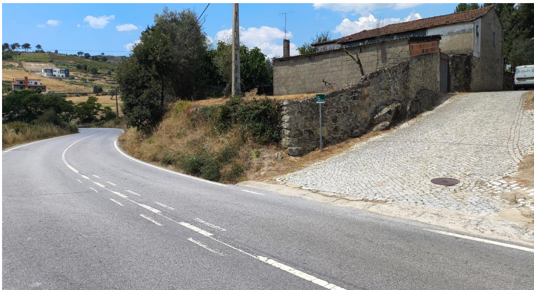
Imagem 3 – cruzamento sem visibilidade no acesso à E.N. 103. ----- c) Caminho Paralelo e Dimensionamento (PK 5+270 a 5+360): Independentemente das considerações supra referidas, o projeto deverá garantir que o caminho paralelo (PK 5+270 a 5+360) apresente largura de plataforma e raios de viragem nas intersecções que permitam a manobra segura de veículos de emergência e maquinaria agrícola pesada. Propõe-se, como
